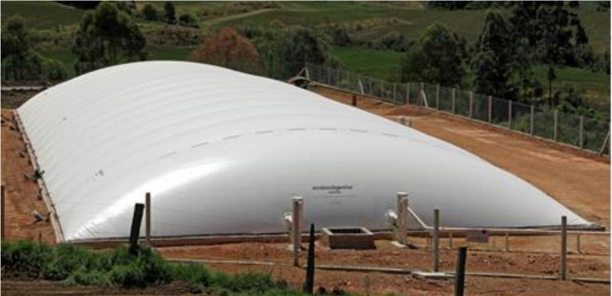
**Figura 2.5** – Biodigestor modelo canadense, gasômetro de PVC.
